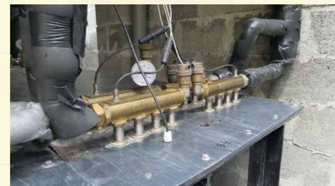
Rekuperattorisarjan kokoojakeräimet, joihin on asennettu anturit
